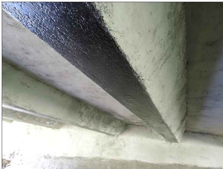
Podhled nosníku s ochranným nátěrem.
